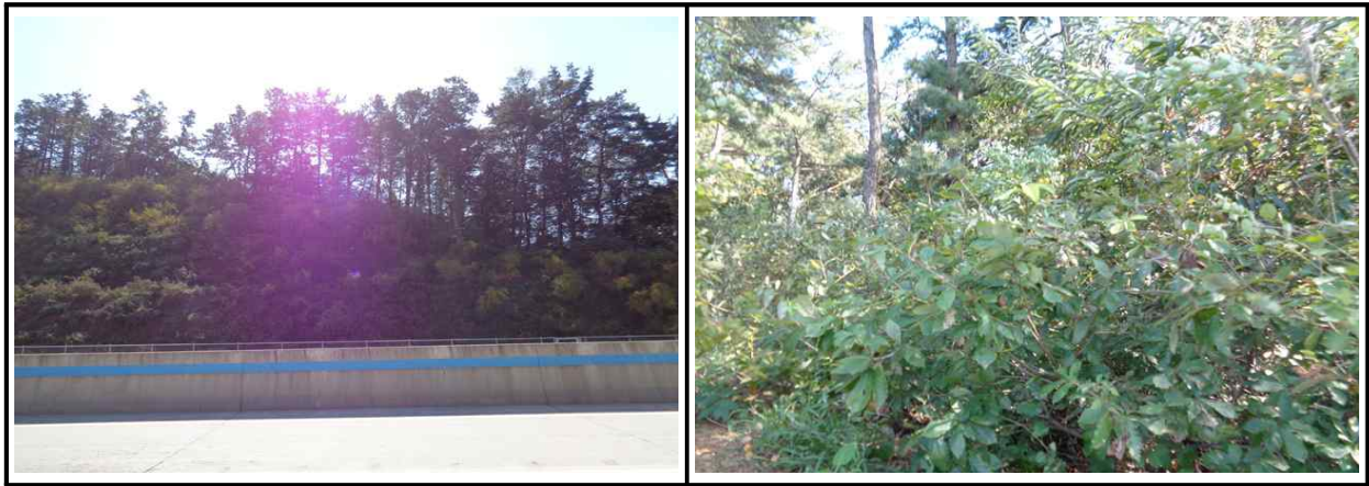
【그림 2.3.1】 상부자연사면 전경
