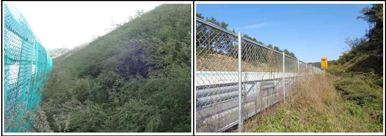
【그림 2.3.4】 보호/보강시설 전경
